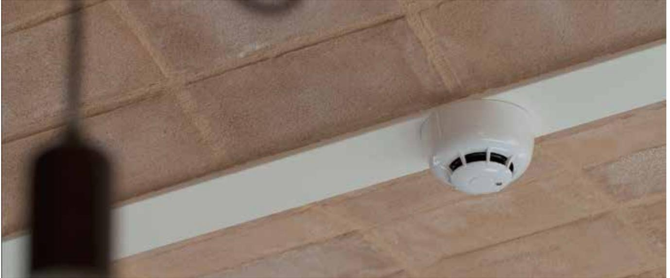
FD100, rivelatore di fumo via radio bidirezionale in grado di monitorare il livello di polvere della camera ottica, così da segnalare l'eventuale necessità di una pulizia della camera ottica stessa. Sensibilità della rivelazione programmabile su 4 livelli da 0,08dB/m
